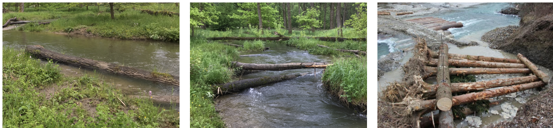
(a) Einzelne Stamm-Struktur in der Alme, bei Lippstadt (b) Mehrstamm-Struktur in der Alme, bei Lippstadt (c) Engineered Log Jam in der Aare, Löchligut Bern (Schweiz), Emsch+Berger (2022)
