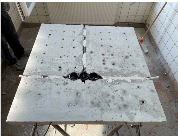
Abbildung 6: Integrierte Leerrohre und Unterputzdosen [Quelle: TU Dresden, IBB]
