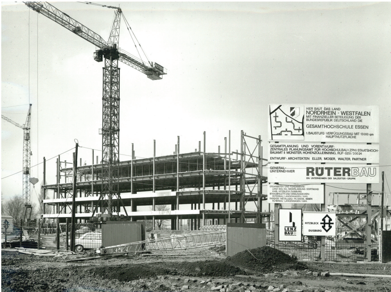
Abb. 43: Baubeginn des Westflügels des Bargmann-Hauses (1973)
