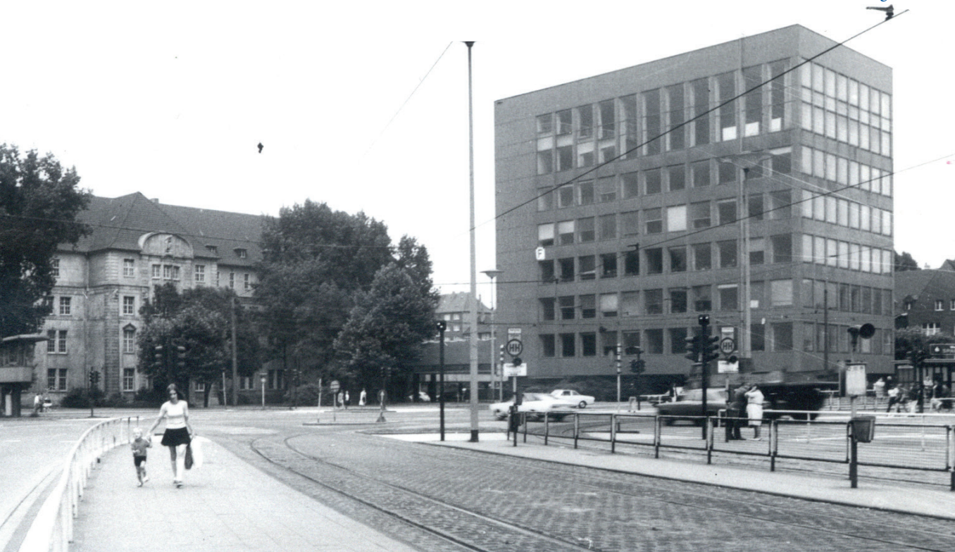
Abb. 9: Standort der Fachhochschule Essen an der Schützenbahn, heute Gebäude S-A und S-H der Universität Duisburg-Essen
