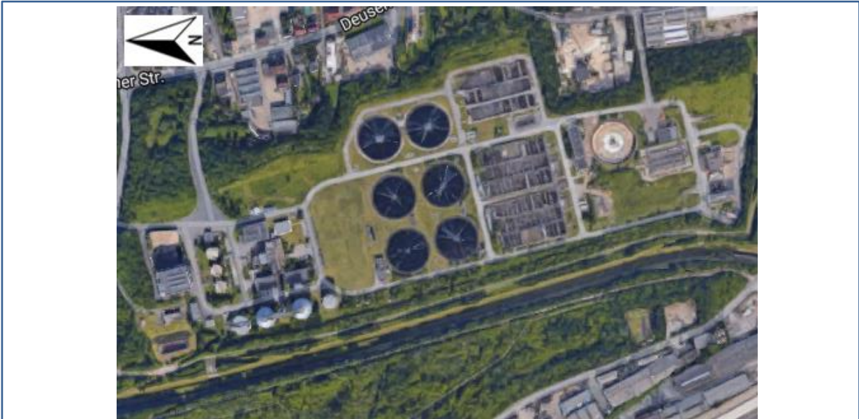
Abbildung 87: Luftbild der Kläranlage Dortmund Deusen (GeoBasis-DE/BKG 2009)
