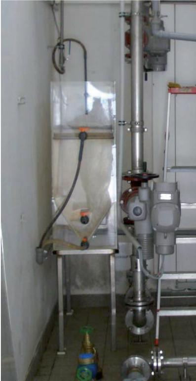
Abb. 4-14: Sedimentationsbecken der Ruhr-Überwachungsstation-Hattingen
