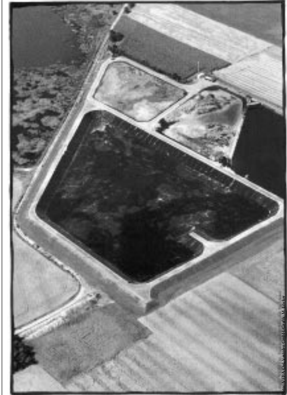
(2) Mülldeponie. Die für die Abdichtung verwendeten Kunststoffe dürfen auch nach einem Zeitraum von 100 Jahren ihre Dichtungsfunktion nicht verlieren
