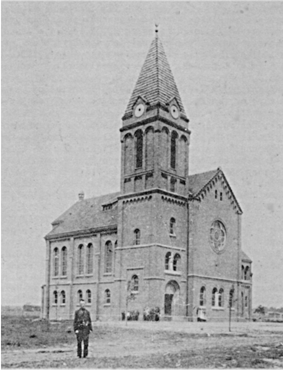
Abb. 396: Außenansicht, Zustand unmittelbar vor Fertigstellung
