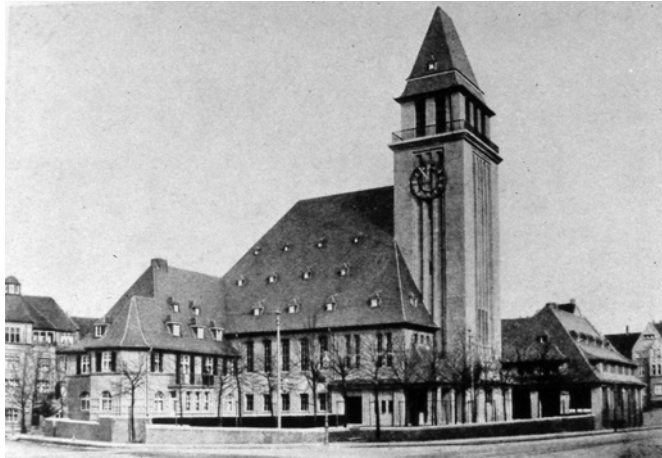
Abb. 462: Außenansicht der Gebäudegruppe, Zustand nach Fertigstellung
