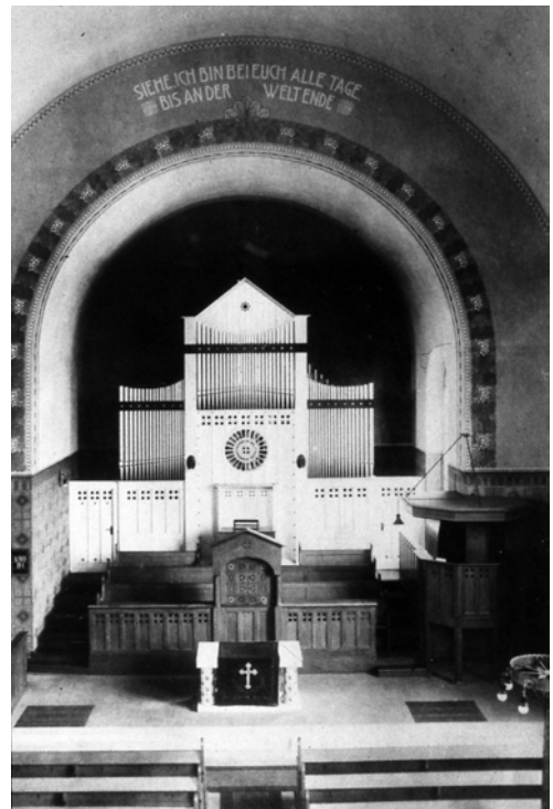
Abb. 420: Innenansicht, Zustand bei Fertigstellung
