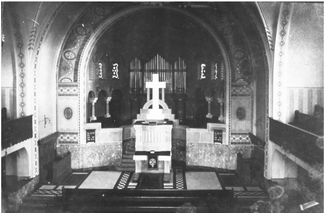
Abb. 428: Innenansicht, Zustand bei Fertigstellung
