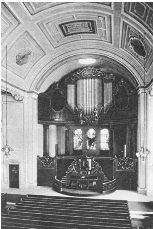
Abb. 485: Innenansicht, Zustand nach Fertigstellung
