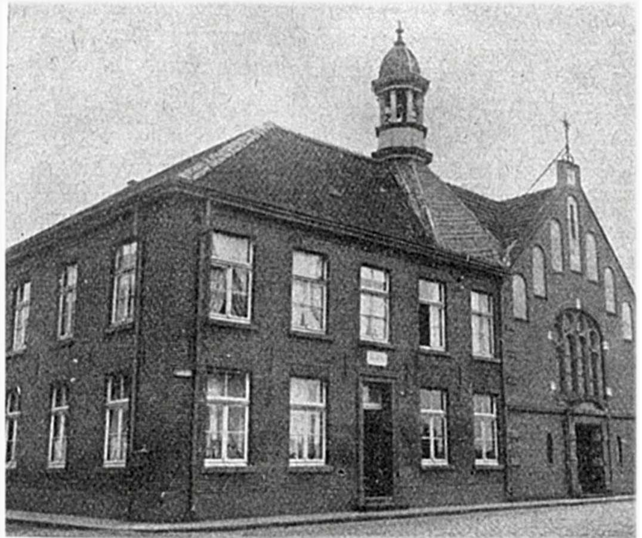
Abb. 404: Ehemaliges Schulhaus und Kirche, Zustand nach dem 2. Weltkrieg vor den Umbaumaßnahmen
