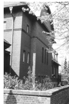
Abb. 486: Außenansicht, Ostseite der Kirche, April 1997
