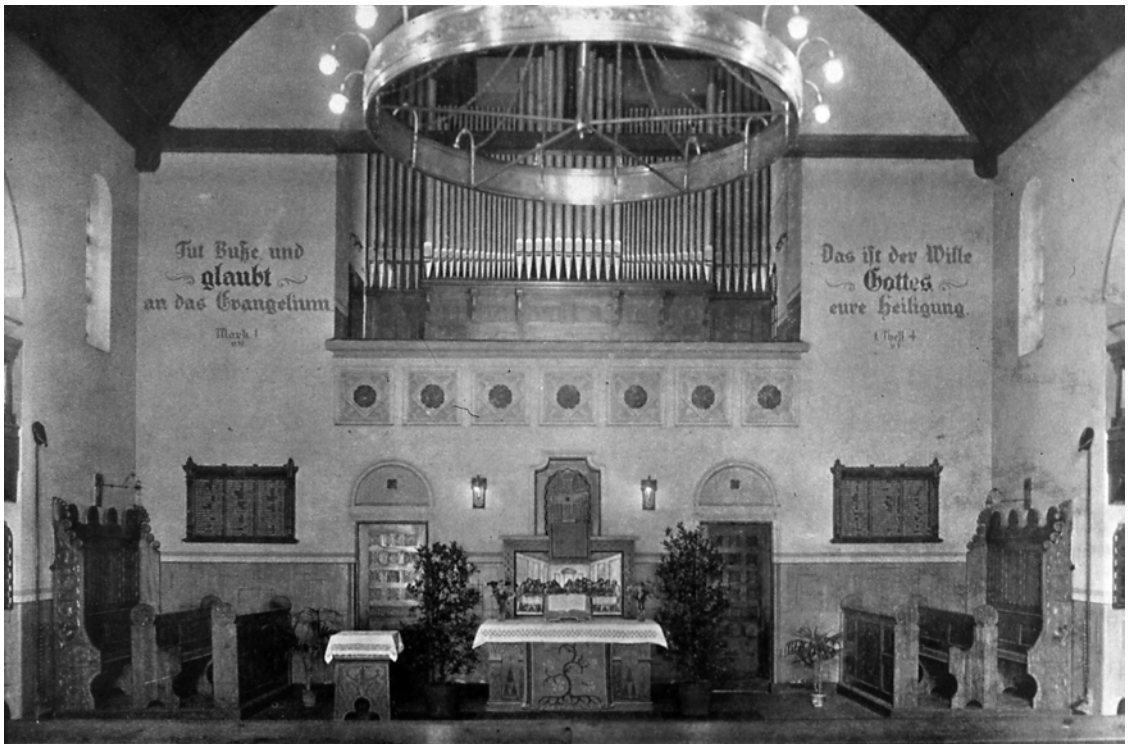
Abb. 447: Innenansicht, Zustand nach Fertigstellung
