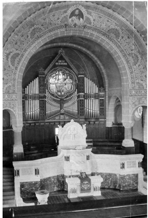
Abb. 391: Innenansicht, Zustand nach Fertigstellung
