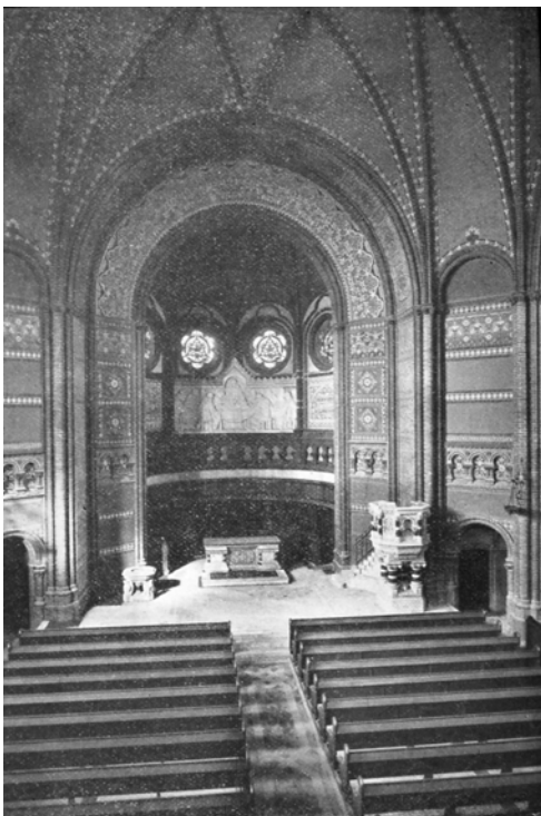
Abb. 325: Innenansicht, Zustand nach Fertigstellung
