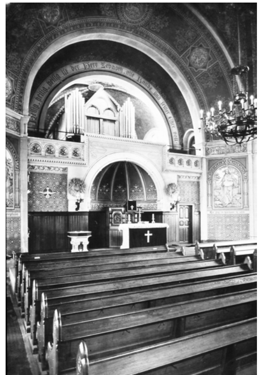
Abb. 320: Innenansicht, Zustand nach Fertigstellung
