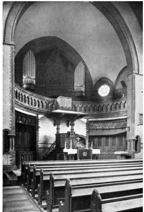
Abb. 334: Innenansicht, Zustand nach Fertigstellung
