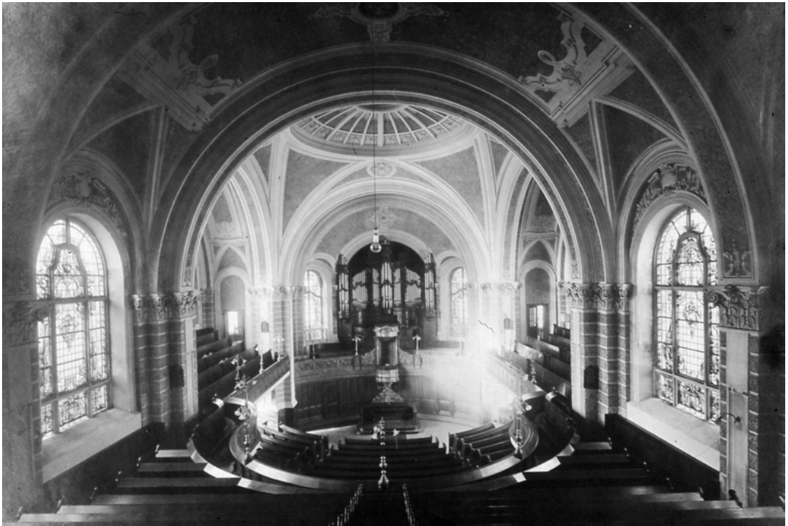
Abb. 331: Innenansicht, Zustand nach Fertigstellung
