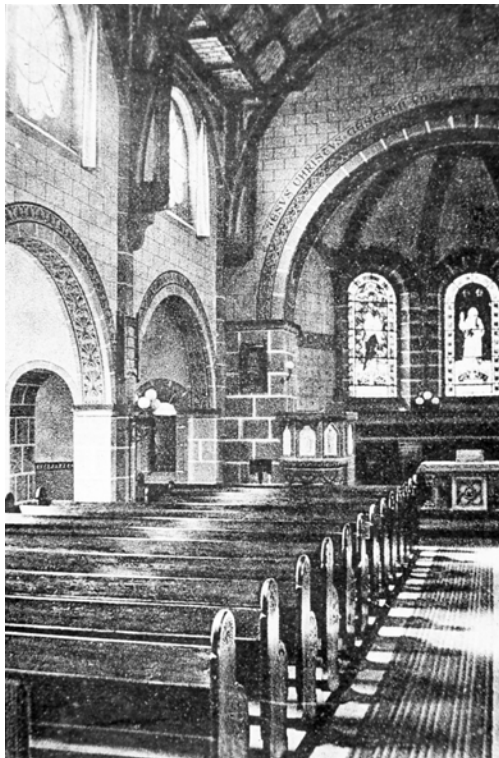
Abb. 315: Innenansicht, Zustand nach Fertigstellung
