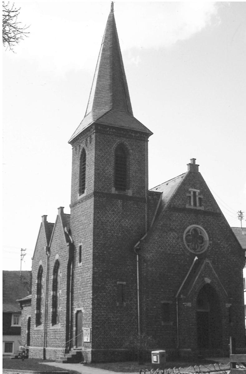
Abb. 321: Außenansicht, Zustand April 1997
