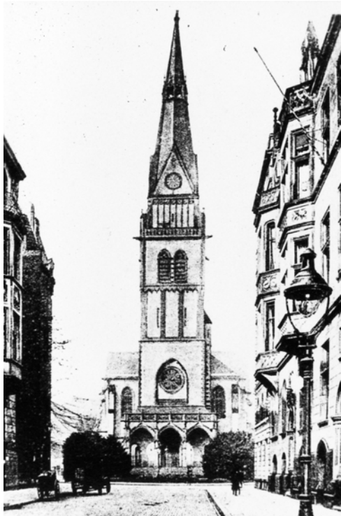
Abb. 246: Außenansicht, Turmfassade mit Haupteingang, Zustand nach Fertigstellung
