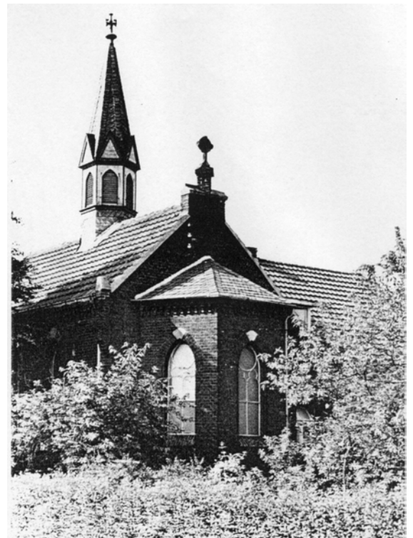
Abb. 230: Zustand vor dem Abriss 1963
