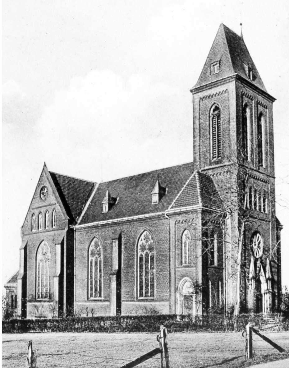
Abb. 235: Außenansicht, Zustand um 1925 nach Abbau des ursprünglichen spitzen Turmhelms
