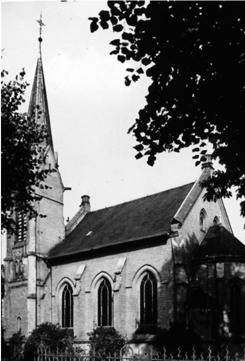
Abb. 268: Außenansicht, Zustand etwa 1960
