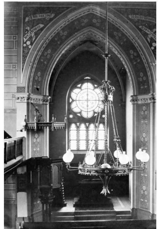
Abb. 221: Innenansicht, Blick von der Orgelepore in die Apsis, Zustand um 1900
