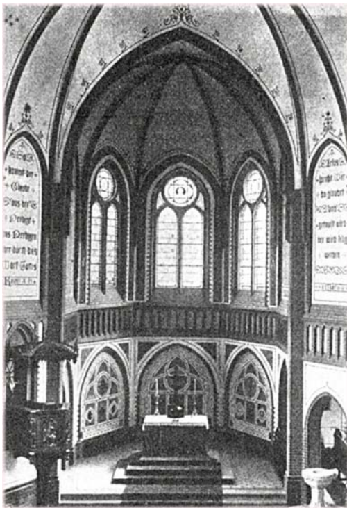
Abb. 216: Innenansicht Chorbereich, Zustand um 1905
