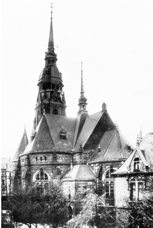
Abb. 224: Außenansicht Chorseite, Zustand nach Fertigstellung
