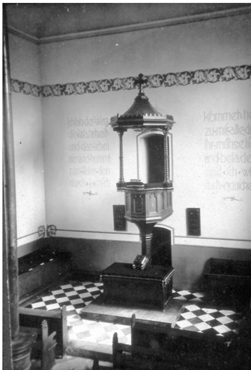
Abb. 36: Innenraum, Blick auf die Kanzelwand, Zustand um 1930
