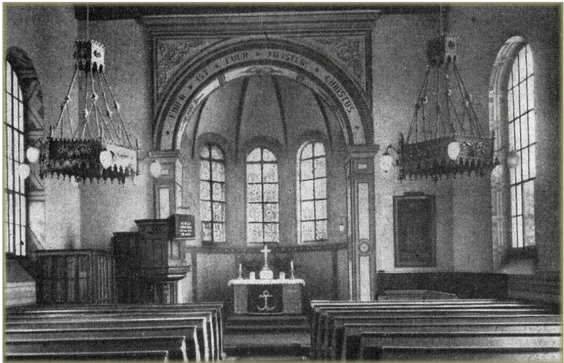
Abb. 89: Innenansicht, Zustand vor der Renovierung 1955
