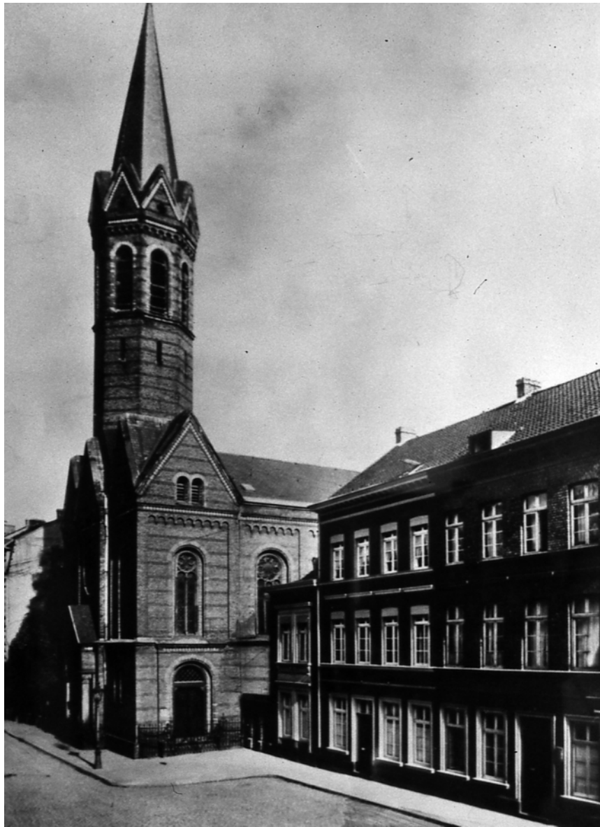
Abb. 38: Tempelstrasse mit Johanneskirche und Pfarrhaus der Gemeinde, Zustand vor dem 2. Weltkrieg
