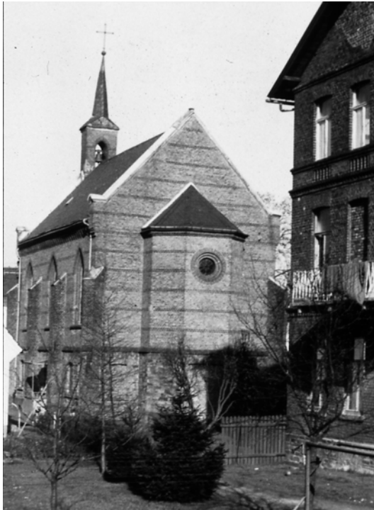
Abb.43: Außenansicht Chorseite, Zustand 1961
