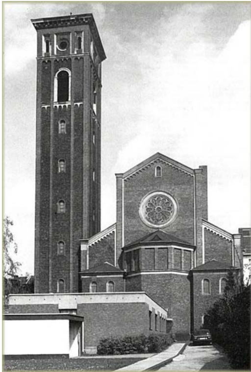
Abb. 30: Außenansicht, Chorseite, Zustand um 1970
