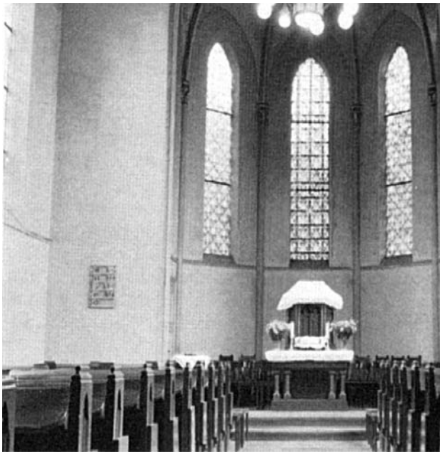
Abb. 41: Innenansicht. Zustand vor dem Abriss 1961/62
