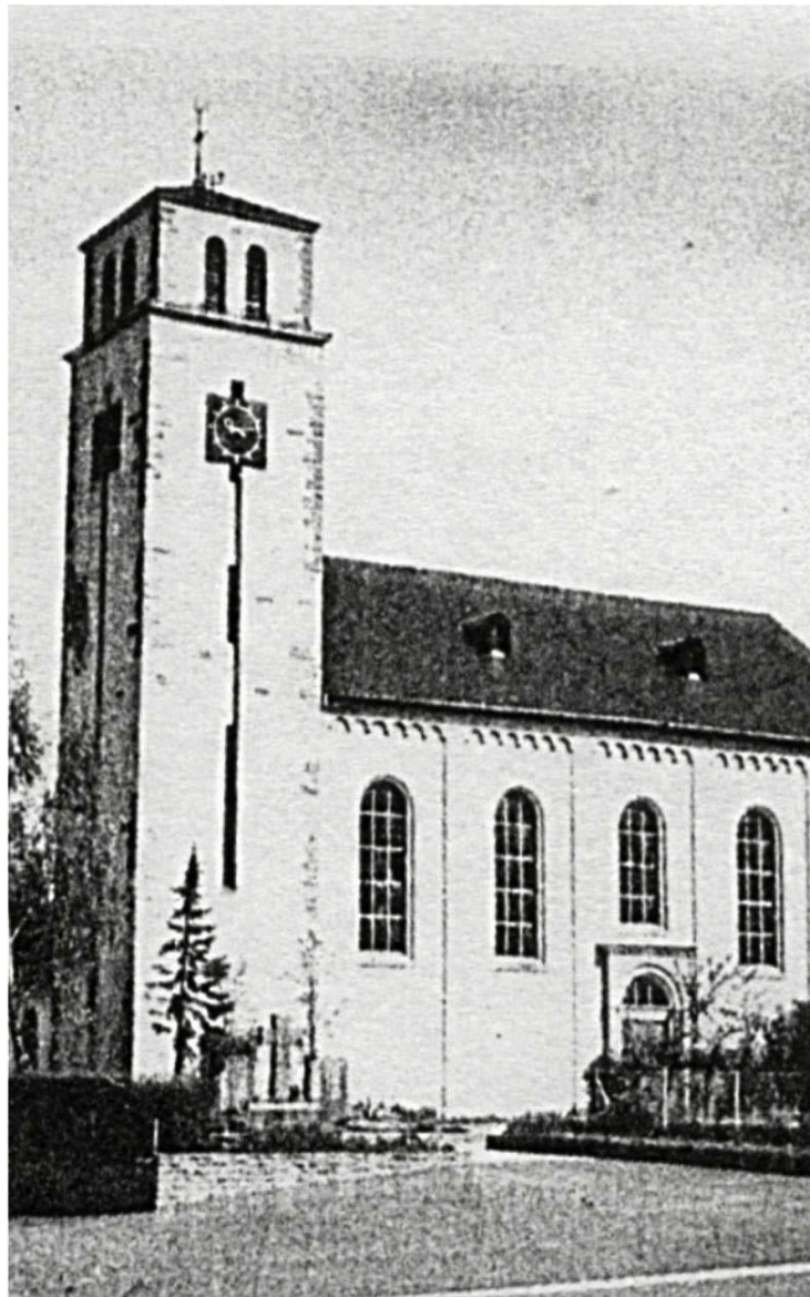
Abb. 106: Außenansicht mit Turm (1930/31), Zustand 1978, wenige Jahre vor dem Abriss des Gebäudes
