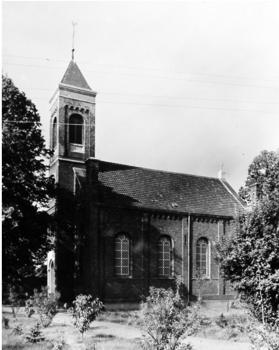
Abb. 94: Außenansicht, Zustand 1955 mit wiederaufgebautem, reduziertem Turmhelm
