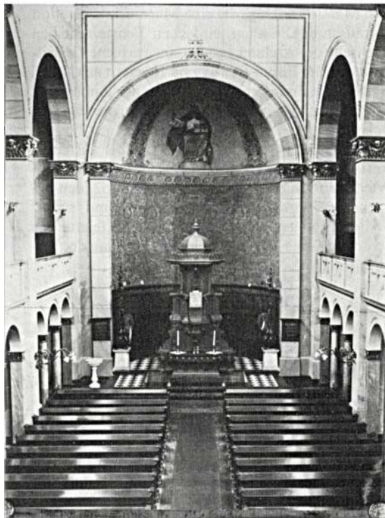
Abb. 31: Innenansicht, Blick von der Westempore in die Apsis, Zustand vor der Zerstörung 1942/43
