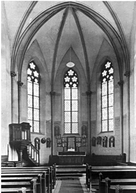
Abb. 109: Innenansicht, Zustand vor der Renovierung 1965/67
