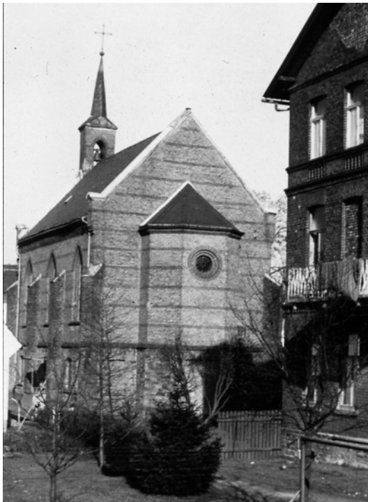
Abb.43: Außenansicht Chorseite, Zustand 1961
