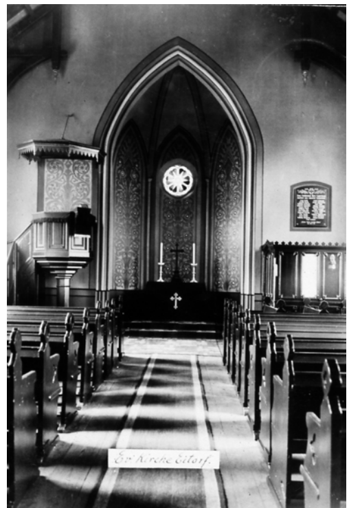
Abb.44: Innenansicht, Zustand vor der Renovierung 1955
