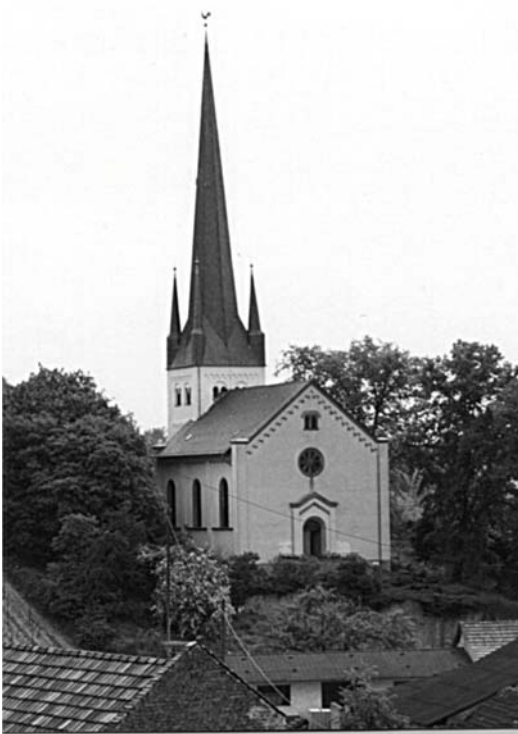
Abb. 52: Außenansicht, Zustand etwa 1995
