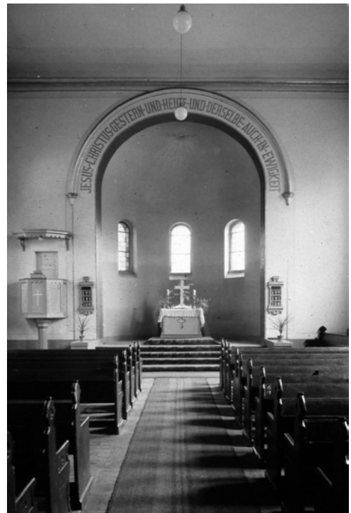
Abb.51: Innenansicht, Zustand vor dem Chorausbau 1961/62
