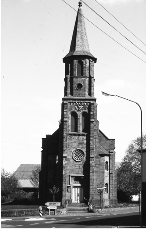
Abb. 57: Außenansicht Turmfassade mit Eingangsbereich, Zustand April 1997
