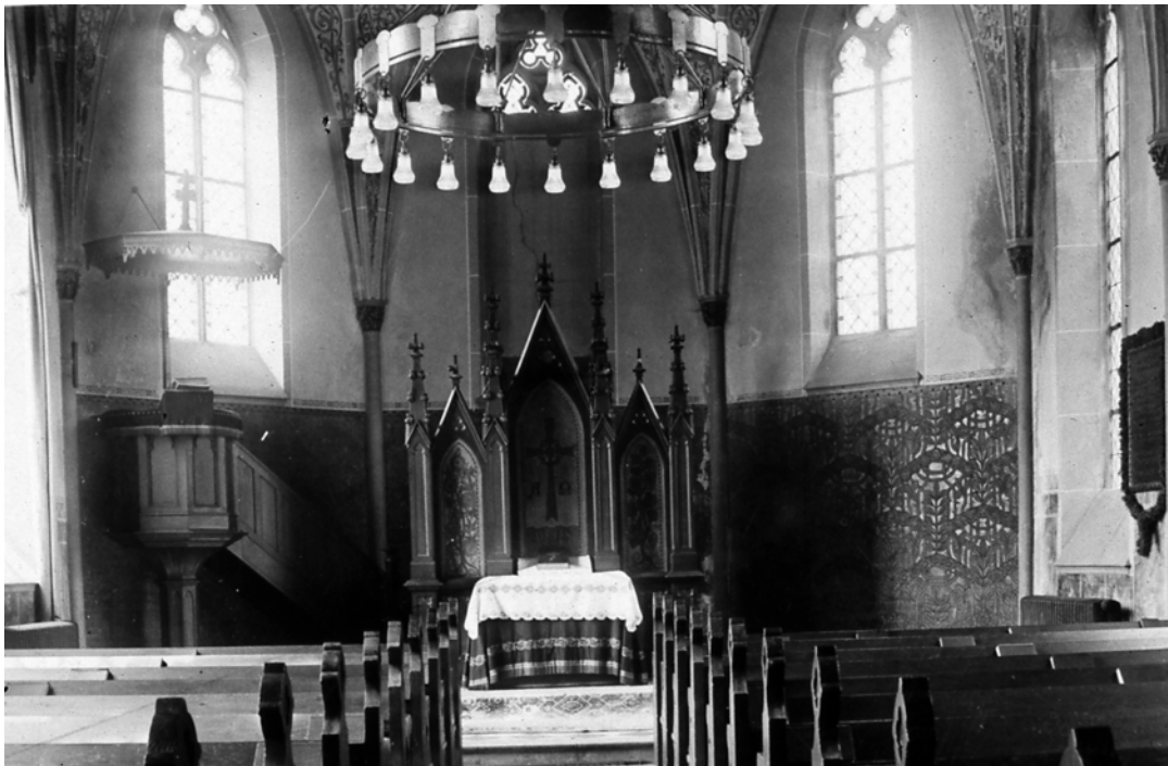
Abb. 91: Innenansicht, Zustand vor der Renovierung 1939
