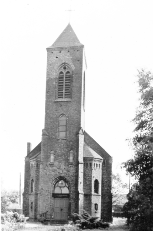
Abb. 192: Außenansicht nach dem Wiederaufbau mit verkürztem Turmhelm, Zustand um 1955
