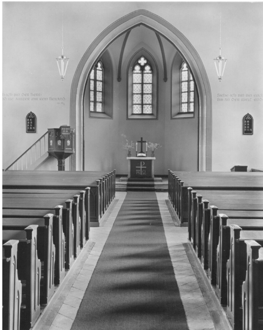
Abb. 132: Innenansicht, Zustand vor der Renovierung 1977
