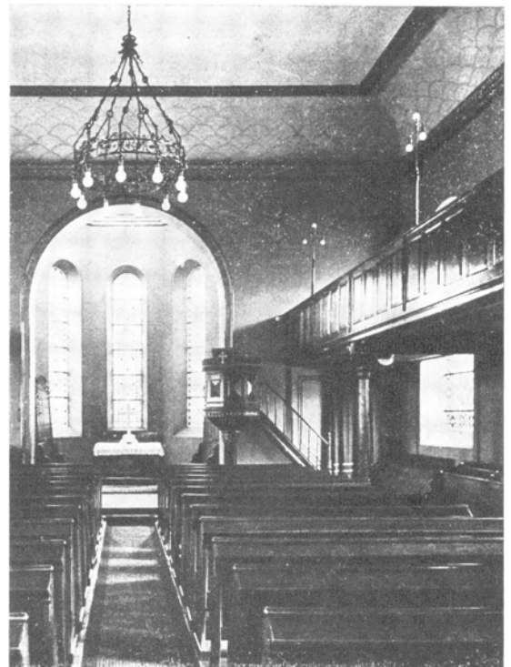
Abb. 152: Innenansicht, Zustand vor der Renovierung 1951
