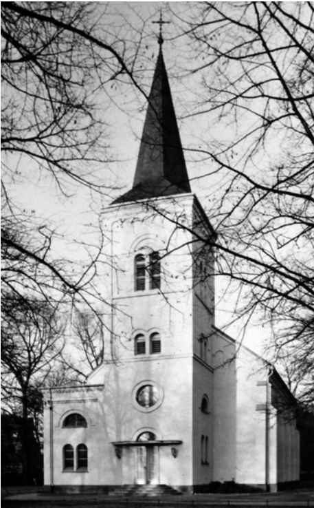
Abb. 151: Außenansicht, Zustand nach dem 2. Weltkrieg
