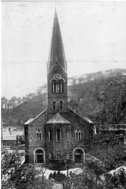
Abb. 178: Außenansicht Turmfassade, Zustand um 1900
