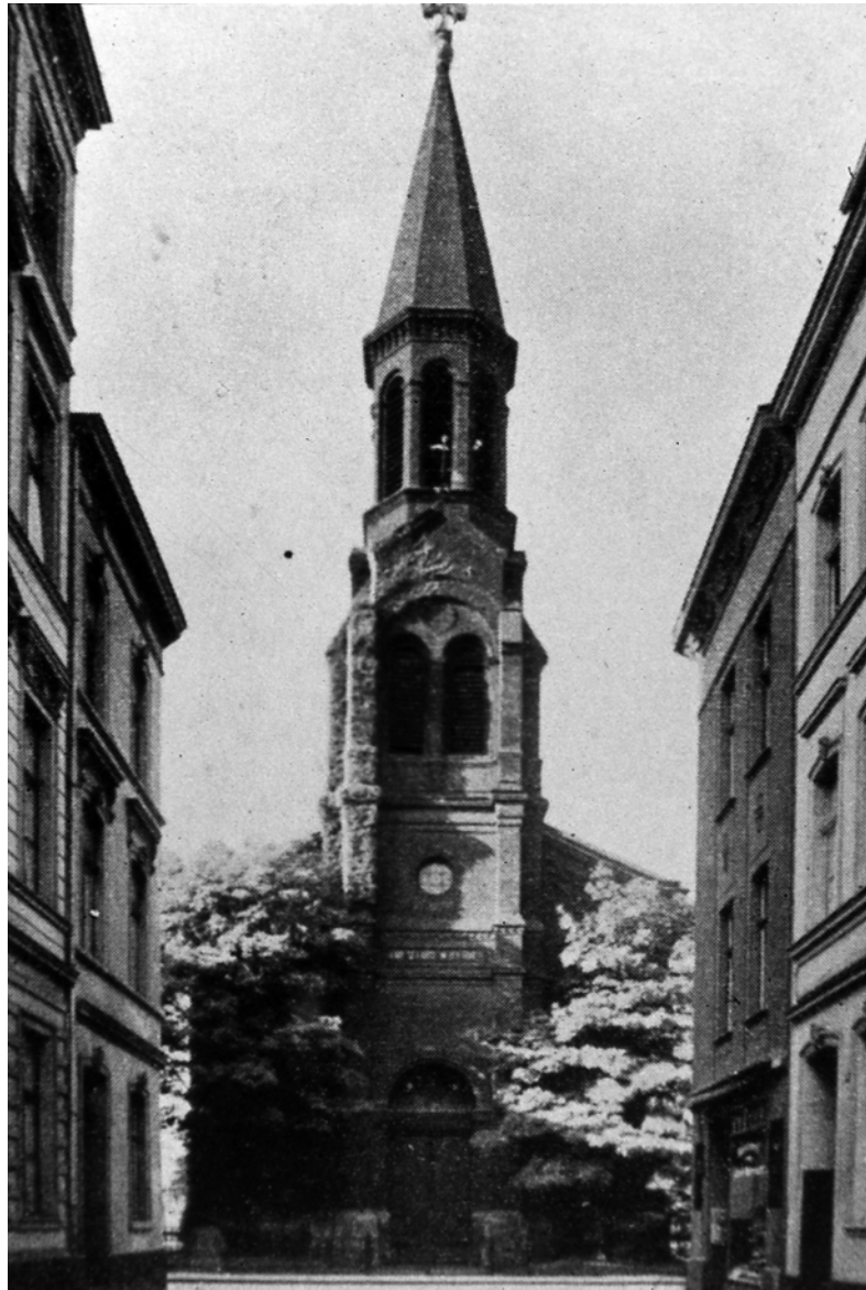
Abb. 141: Außenansicht Eingangsbereich mit Glockenturm, Zustand um 1900
