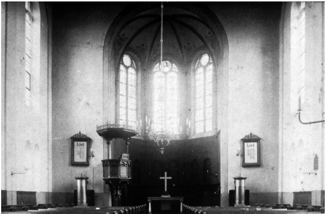
Abb. 140: Innenansicht, Zustand nach der Renovierung 1921
