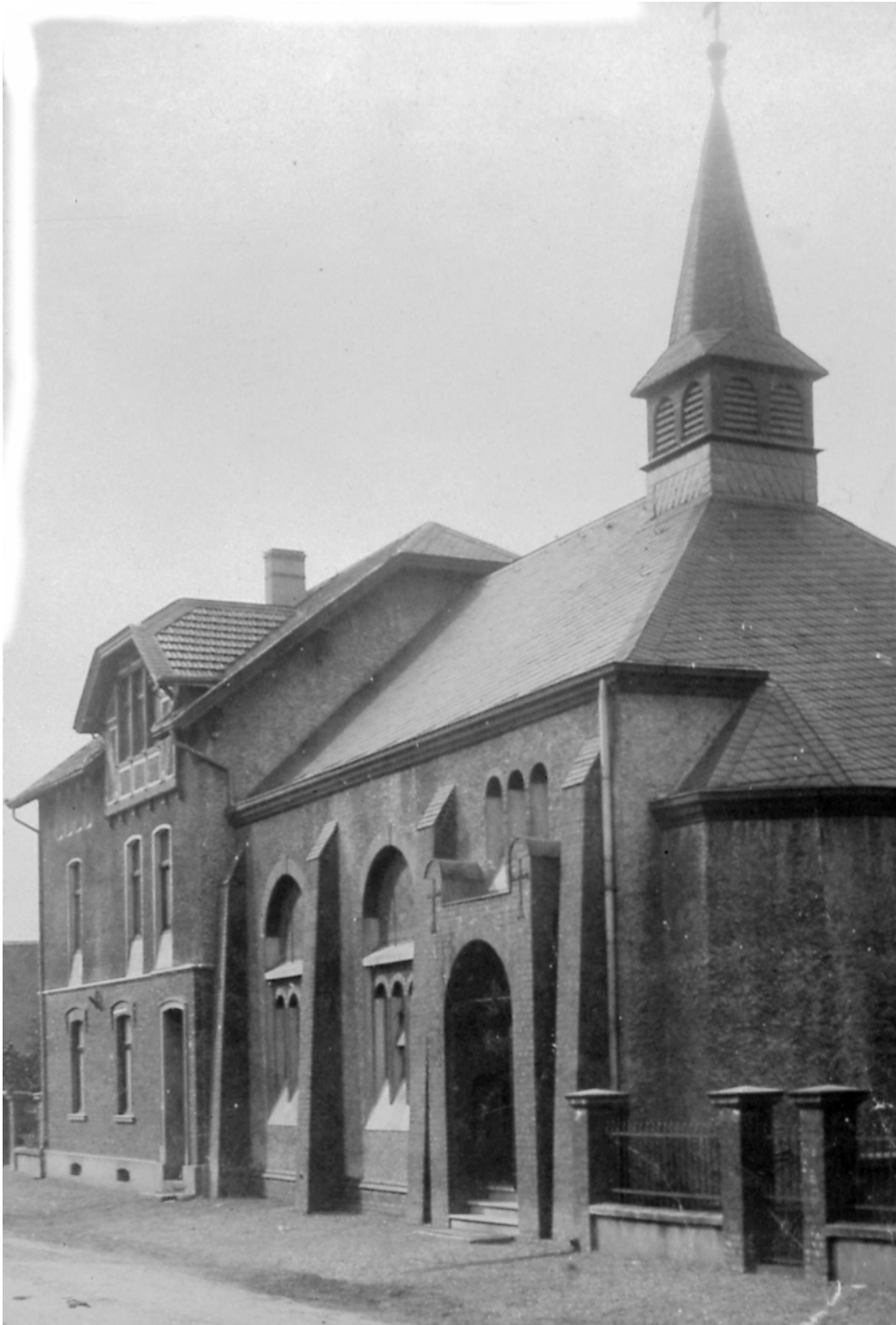
Abb. 28: Betsaal Moers-Schwafheim (1906), Außenansicht, Zustand nach Fertigstellung
